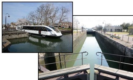
富岩水上ラインと中島閘門
