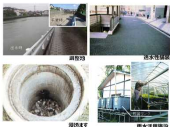
雨水貯留浸透施設の例
