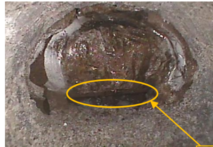
PCグラウト充填状態をはつり調査で確認
