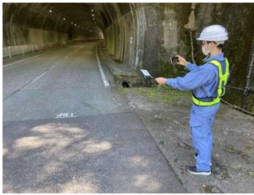
目視により路面性状を確認
