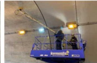
レーダーを利用した トンネル覆工の変状把握
