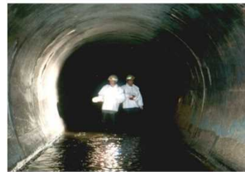
・潜行目視による点検・調査
