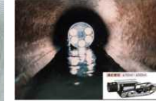
テレビカメラによる 管路の点検・調査
