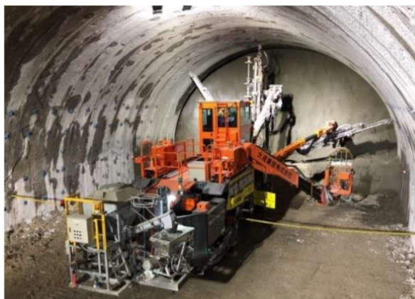
6m継ぎボルト打設装置を搭載した ロックボルト専用ロボット「BOLTINGER」 大成建設/古河ロックドリル
