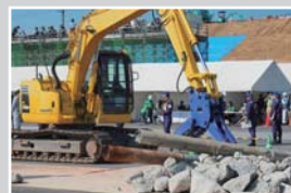
重機によるがれき撤去
