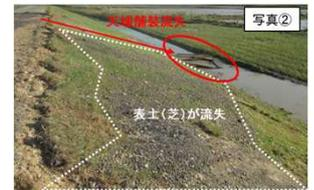
図-3 越水後決壊無し(那珂川) 写真②
