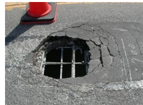
【道路が損傷した例】
