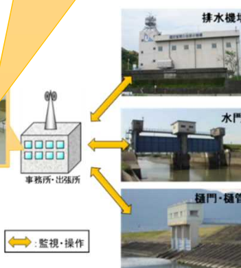
事務所など遠隔地からも監視・操作が可能
