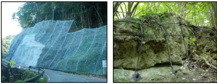
落石防護網工
