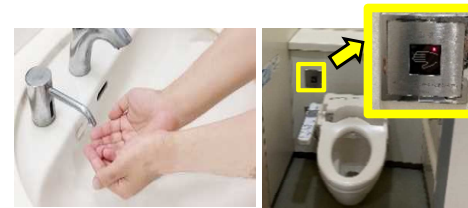
自動水栓・水石けん供給栓 自動洗浄装置
