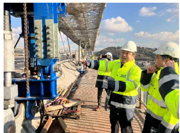
補修工事中の第2ボスポラス海峡大橋の視察
