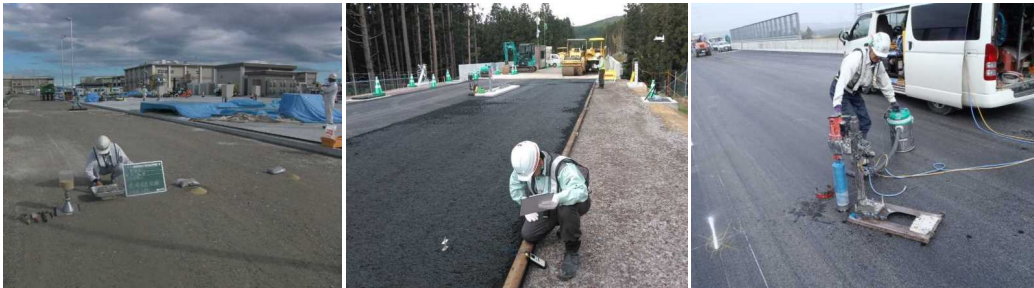
砂置換法による路盤の密度管理 温度計による転圧温度測定 コア採取による舗装の密度管理
