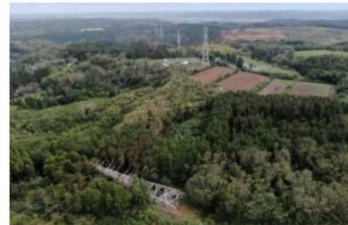
台風15号により倒壊した鉄塔
