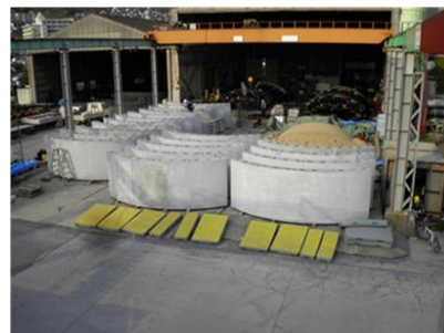
リング状のプレキャストコンクリートの製造 出典：戸田建設株式会社
