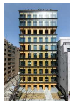
純木造 11階建て研修所
