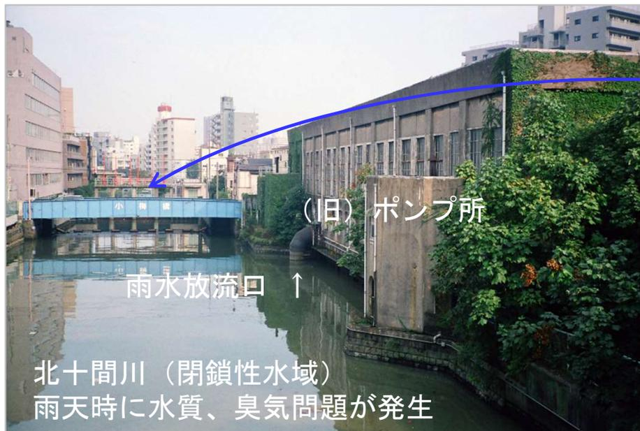
(対策後) ポンプ所再構築に伴う雨水放流先の変更
