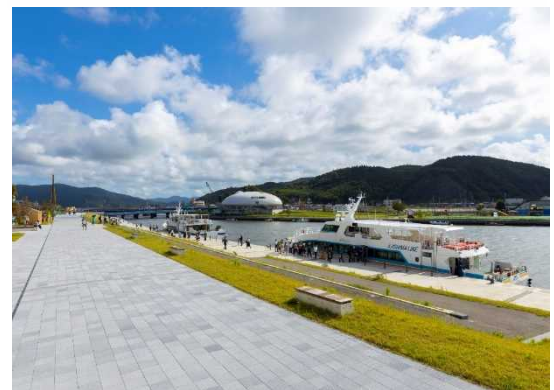
石巻地区かわまちづくり (宮城県石巻市)
