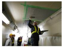
橋梁やトンネル、樋門、水門等のコンクリート構造物からのコンクリート片の剥落を防止する「新素材繊維接着工(コンクリート剥落対策技術)」は、新技術情報提供システム(NETIS)に多数の技術が登録されています。このため、新技術活用システムのテーマ設定型(技術公募)に基づき、新技術の活用促進を目的として、平成 29 年9月に各技術の特性を明確にした技術比較表を作成・公表したところです。
