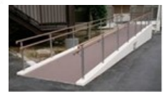
スロープの設置
