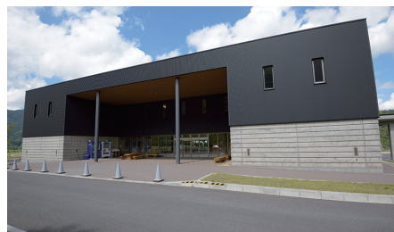
トイレがあるダム管理棟
