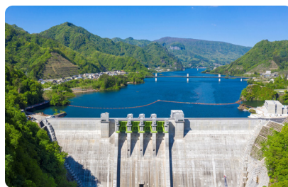
ハッ場ダム (関東地方整備局 / 群馬県吾妻郡長野原町)
