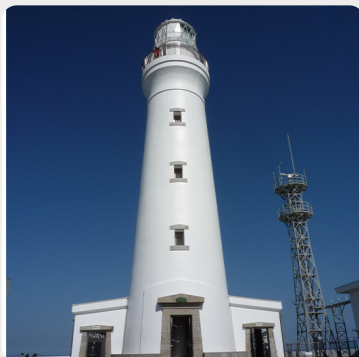
灯台の施設内部及び灯台資料展示館を見学 (千葉県 犬吠埼灯台)
