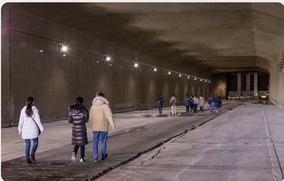
海底トンネルに潜入！東京湾アクアライン裏側探検 (東京都 / 千葉県 東京湾アクアライン・海ほたる)
