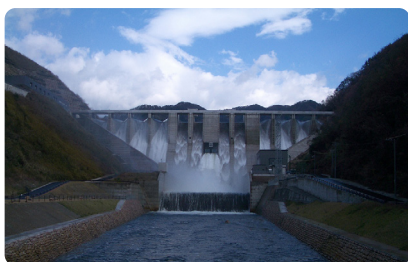
苫田ダム (中国地方整備局 / 岡山県苫田郡鏡野町)
