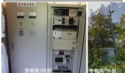
放流警報設備改良 (様似ダム、矢別ダム、小平ダム、庶路ダム)
