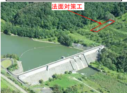
貯水池法面对策(浦河ダム)
