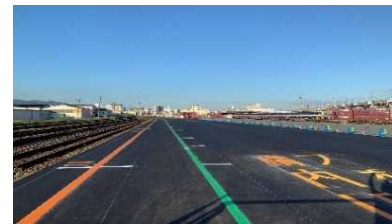
コンテナホームの拡幅等による貨物列車⇄トラック積替え効率化
