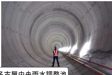
建設中の名古屋中央雨水調整池
