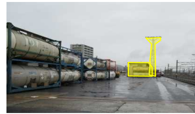
線路・電柱・架線等の撤去
