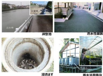
雨水貯留浸透施設の例
