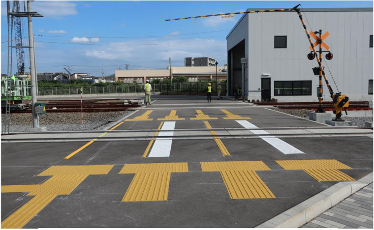
写真 2-7-19 本実験の誘導表示等の敷設状況
