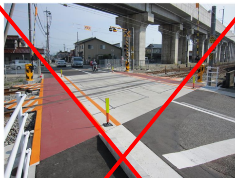
写真 2-1-28 カラー舗装の例
