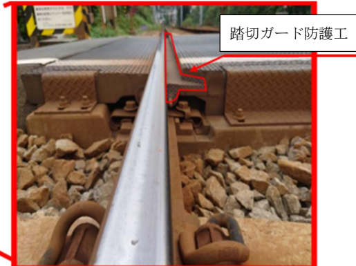
写真 2-7-34 踏切ガード防護工の設置事例
