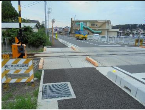
写真 2-1-27 縁石等により分離している例
