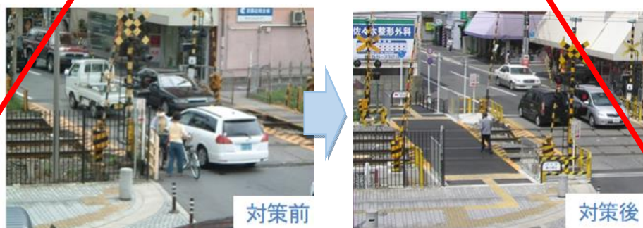
写真 2-1-26 踏切拡幅（歩道新設）の例
