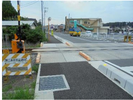
写真 2-7-31 ブロック等により分離している例
