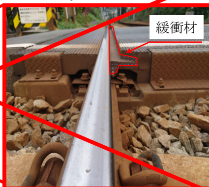
写真 2-1-33 緩衝材の設置事例
