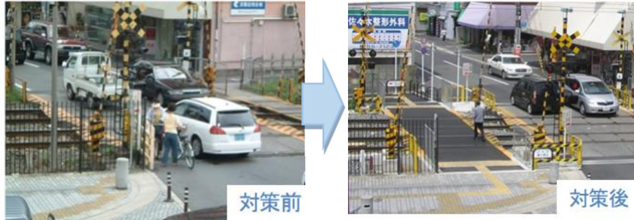
写真 2-7-23 踏切拡幅（歩道新設）の事例
