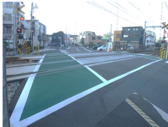
写真 2-7-24 カラー舗装を導入した事例
