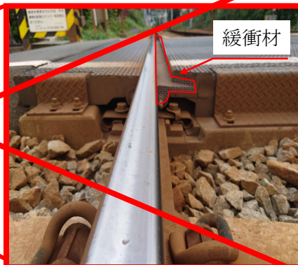
写真 2-1-33 緩衝材の設置事例
