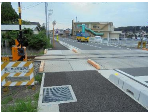
写真 2-1-27 縁石等により分離している例
