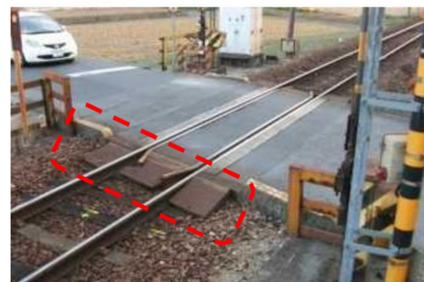
写真 2-7-33 スロープの設置事例
