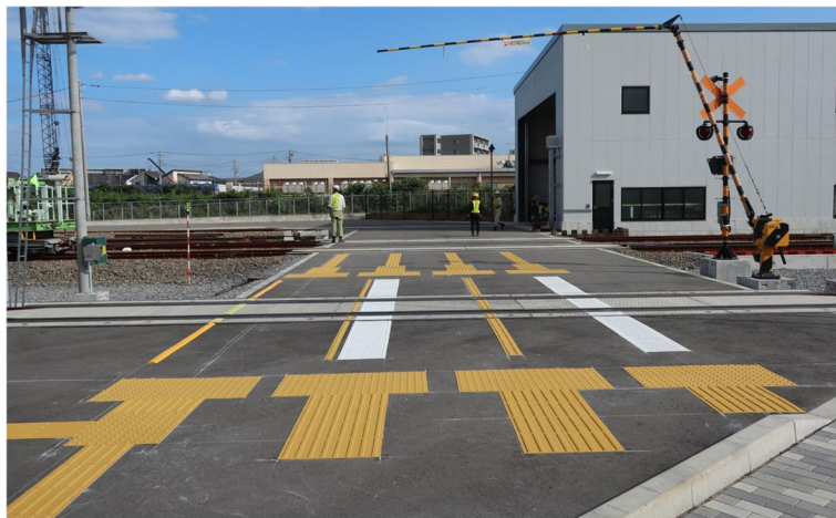
写真 2-7-19 本実験の誘導表示等の敷設状況
