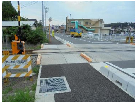
写真 2-7-31 ブロック等により分離している例
