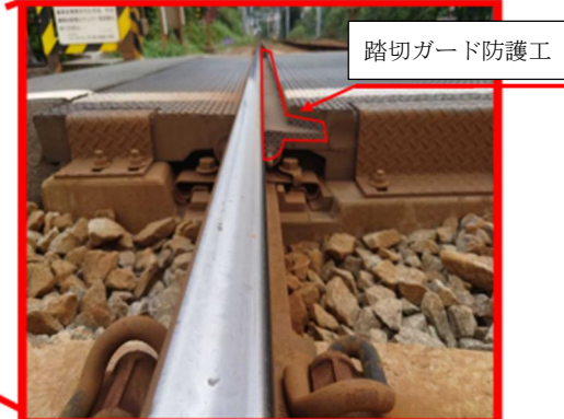
写真 2-7-34 踏切ガード防護工の設置事例
