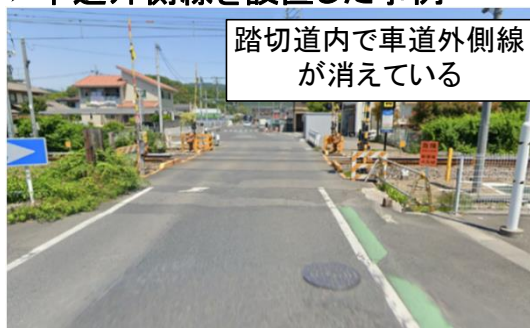
➤車道外側線を設置した事例
