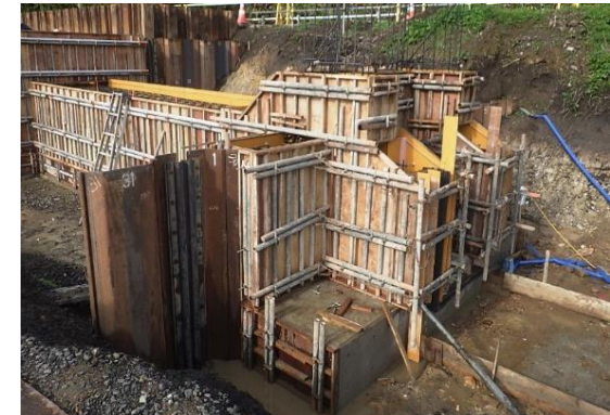
型枠工（省力化構造）
