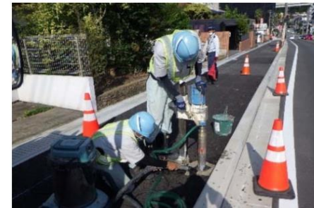
舗装版削孔工
