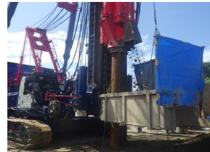
鋼管・既製コンクリート杭打工(中掘工)
