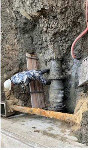
汚水管の復旧工事
