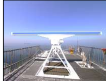
レーダーの整備
