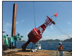
<灯浮標の設置>
