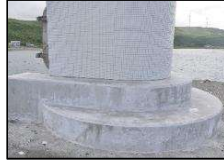
基礎部亀裂補修 (環境遮断)
