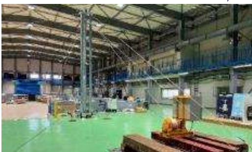
簡易支柱およびウインチ
