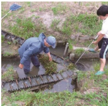
① 水路と水田を結ぶ水田魚道
