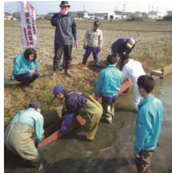
④ 集落総出で魚道を設置
