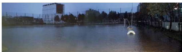
(事例) 校庭を活用した流域貯留施設
