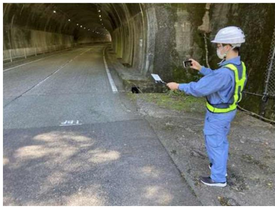
目視により路面性状を確認
