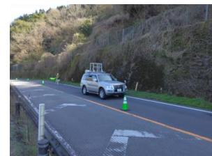
MMS※1を活用した 斜面・のり面点検
