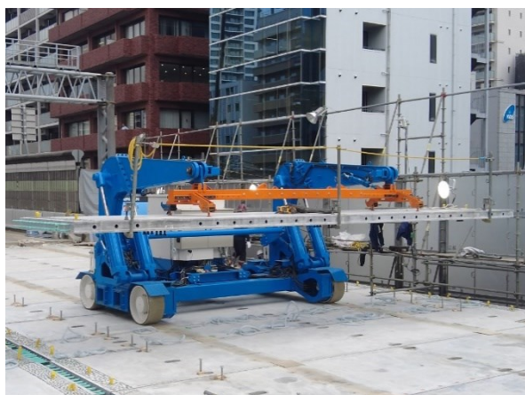
写真一 床版搬送中
