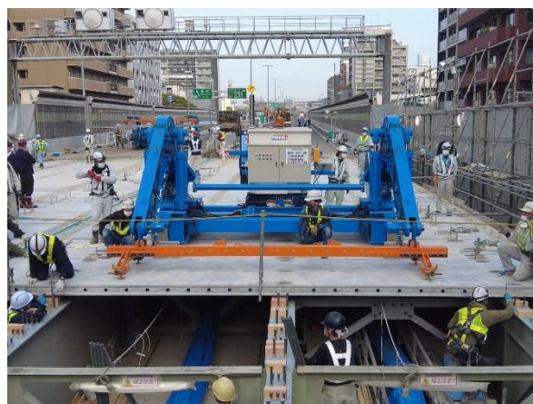
写真二 床版架設中
