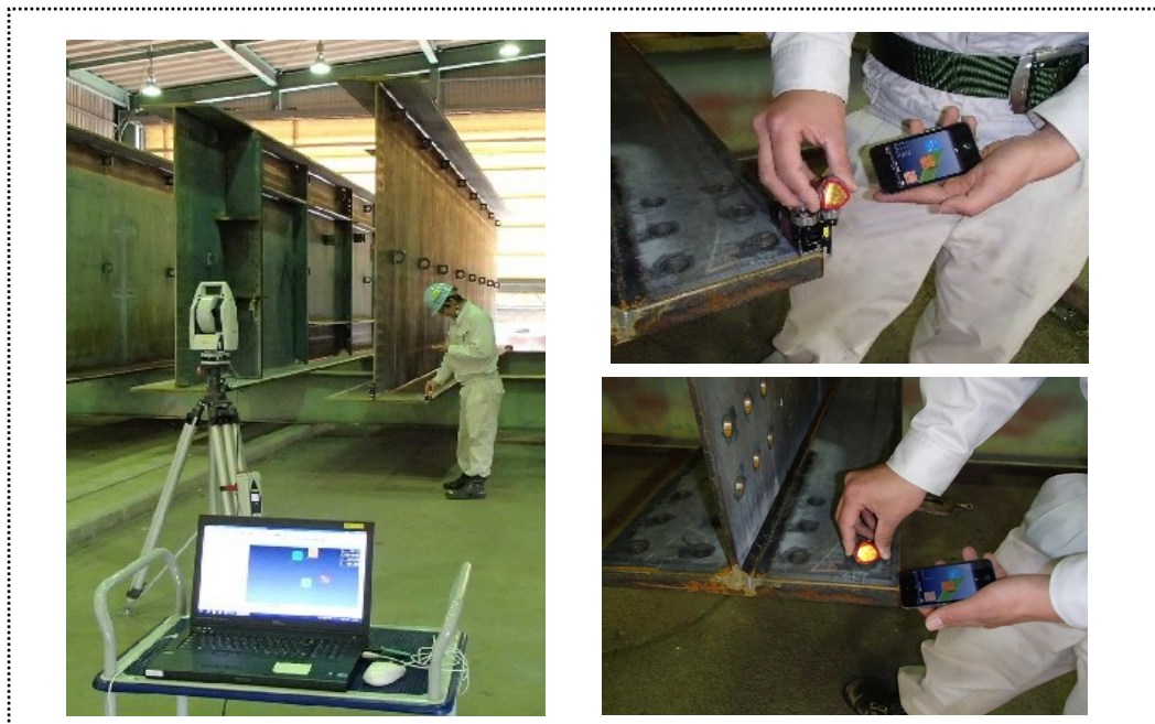
写真－１ 現場での計測施工状況
