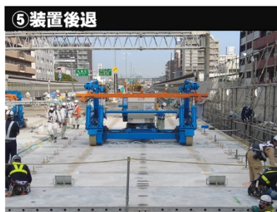
写真一 架設工程
