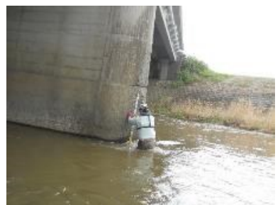
手作業による下部工洗堀状況の計測
