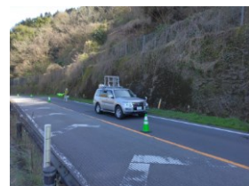
MMS※1を活用した 斜面・のり面点検
