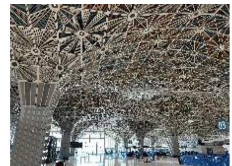
■新国際線ターミナル整備の状況 (2024年7月17日)
