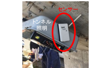
トンネル内附属物の 異常監視センサー
