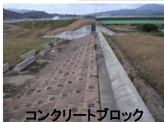
越流堤の構造の例
