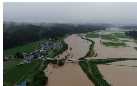
いわみがわ 雄物川水系岩見川付近の浸水状況 （秋田県秋田市）
