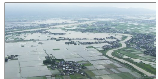
こいしわがわ 筑後川水系小石原川付近の浸水状況 (福岡県大刀洗町)
