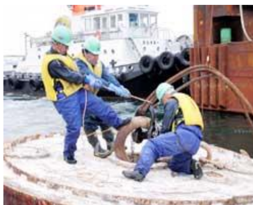
写真4：不安定な足場での繫船作業（函館港）
