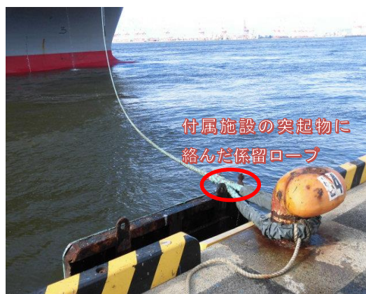
写真8：付属施設に絡んだ係留ロープ
