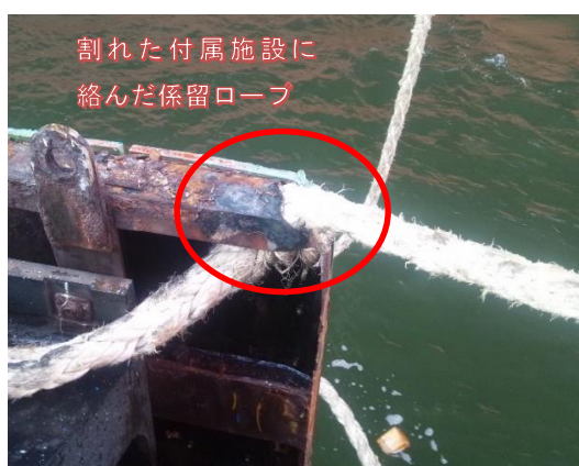
写真9：付属施設に絡んだ係留ロープ
