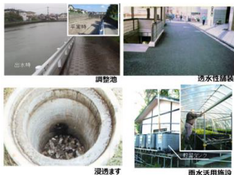
雨水貯留浸透施設の例
