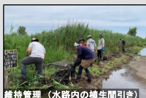
維持管理(水路内の植生間引き)
