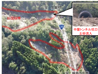
(大雨被災状況 R6. 9)
