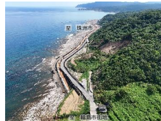
(復旧状況 R6. 8)
