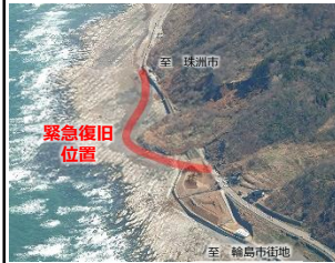
②千枚田工区 (地震被災状況 R6. 1)
