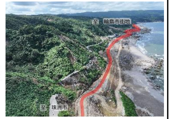
(復旧状況 R6. 9)
