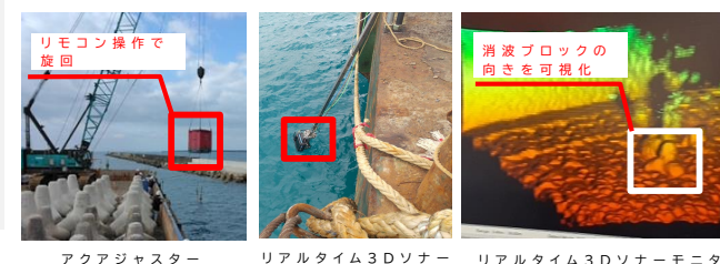
③ アクアジャスターとリアルタイム3Dソナーによる 消波ブロックの向き制御と可視化
