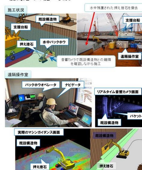
鹿島港での施工状況
