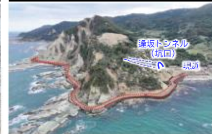
③逢坂トンネル工区
