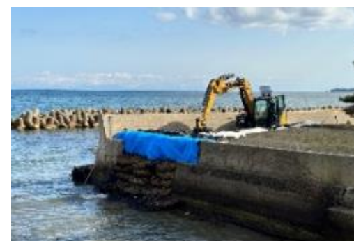
袋詰玉石、大型土のう敷設完了
