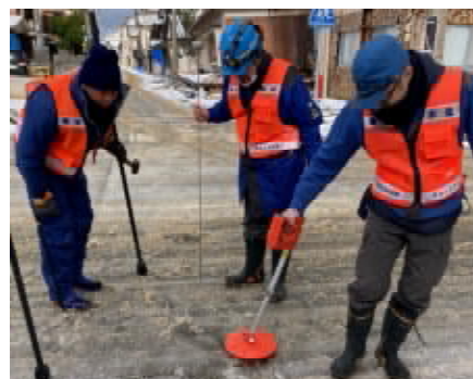
漏水調査(東京都水道局)
