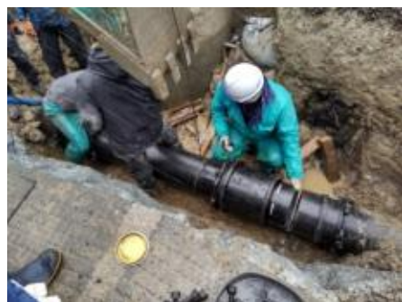
送水管損傷箇所の応急復旧
