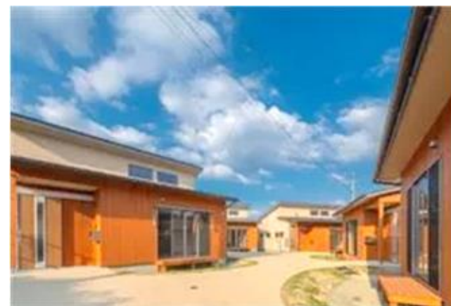
熊本地震後に建設された災害公営住宅（熊本県西原村にて、平成30年完成）
