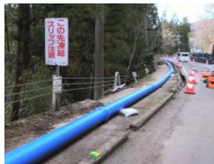
仮設配管による応急復旧
