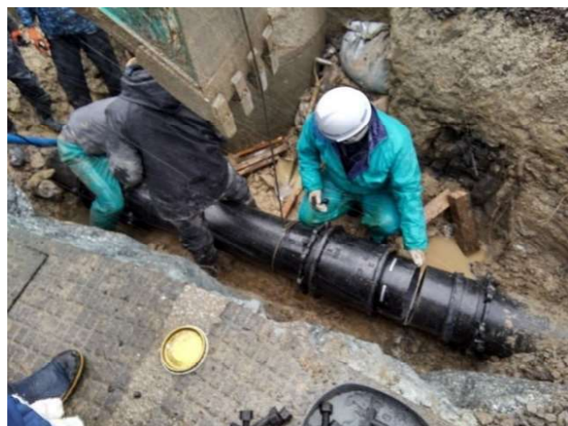
送水管損傷箇所の応急復旧
