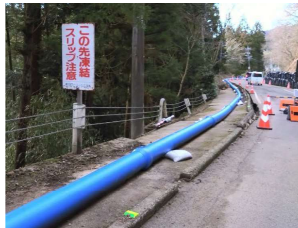
仮設配管による応急復旧
