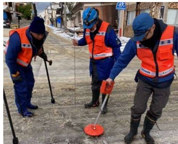
漏水調査(東京都水道局)
