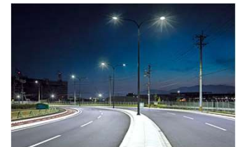
道路照明のLED化
