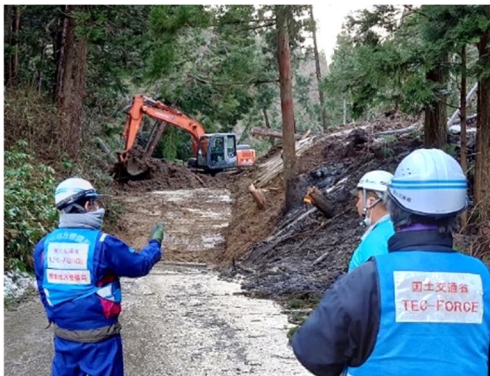
建設業者と連携した道路啓開 (石川県輪島市)
