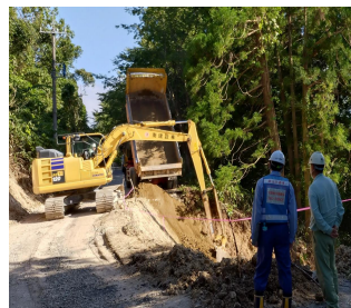
道路啓開作業 (石川県珠洲市)
