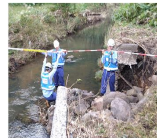
被災状況調査(河川) (石川県輪島市)
