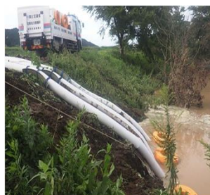
排水作業(町野川) (石川県輪島市)
