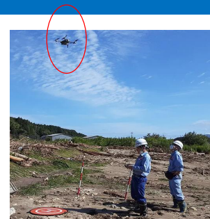
被災状況調査(砂防) (石川県輪島市)
