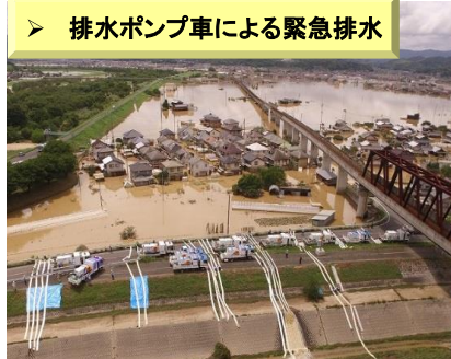
【H30.7月豪雨】 (岡山県倉敷市真備町)
