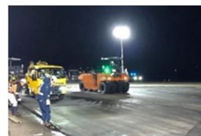
災害復旧工事の例
