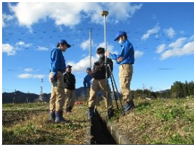
水路の測量（RTK）
