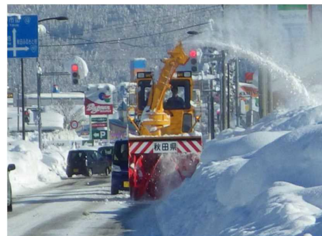
＜拡幅除雪作業状況＞
