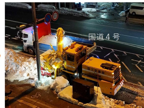
③ロータリ-除雪車でダンプトラックに積み込み
