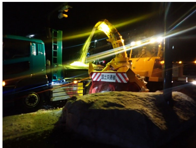
＜排雪作業状況＞
